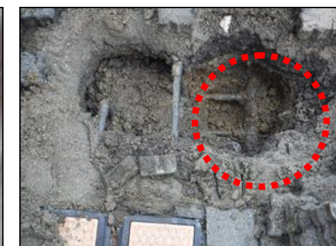
5.特定箇所を掘削し確認
